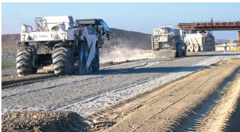
Atelier de traitement de sol.
