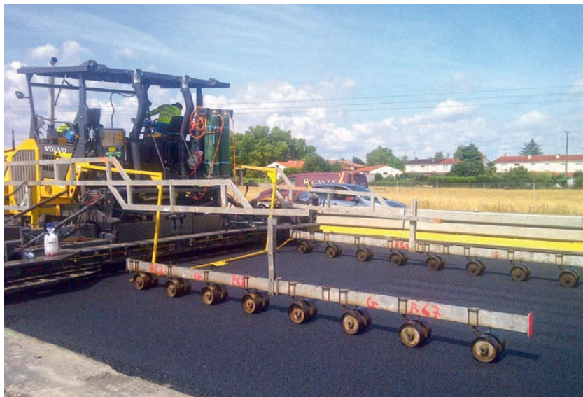
Finisseur de route avec aspiration des fumées.
