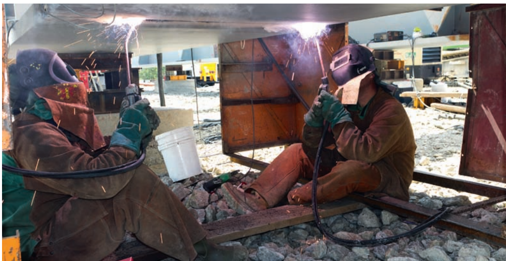
Soudage sur chantier d'une pièce de pont.
