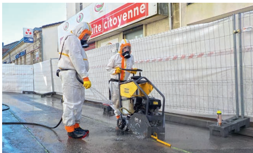
Sciage d'enrobé routier contenant de l'amiante.
