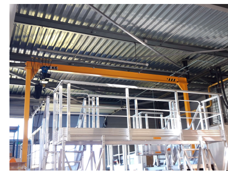
Sécurisation montage véhicule
