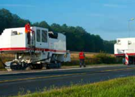
Recyclage en place
