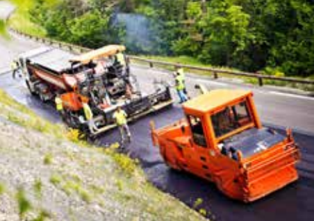
Finisseur et compacteur à l'œuvre
